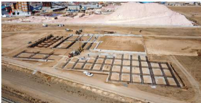
نمایی از شروع پروژه طرح توسعه کارخانه ویسپار
